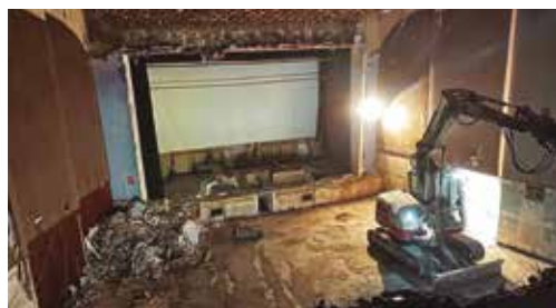
Obras en el cine Lux de Fustiñana.
