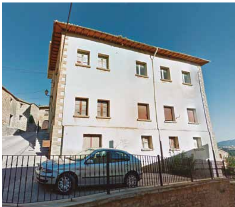
La antigua escuela de Pueyo, donde se ubicará el futuro gimnasio.
