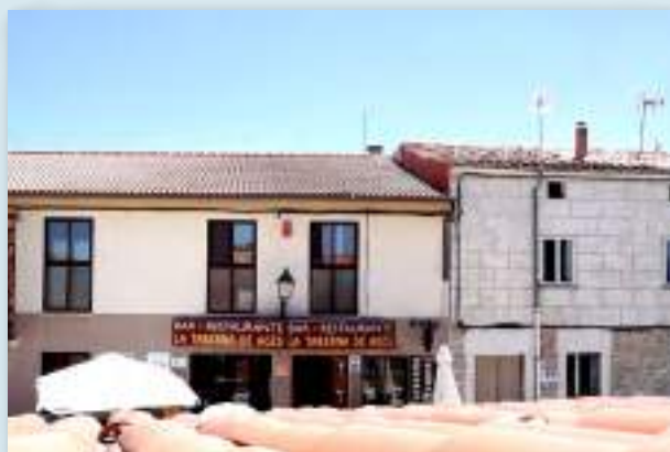
La cubierta del Albergue Municipal de peregrinos (a la izquierda de la imagen) alojará la primera instalación fotovoltaica de Agés, que abastecerá a edificios municipales, alumbrado y doce viviendas particulares de la localidad.
