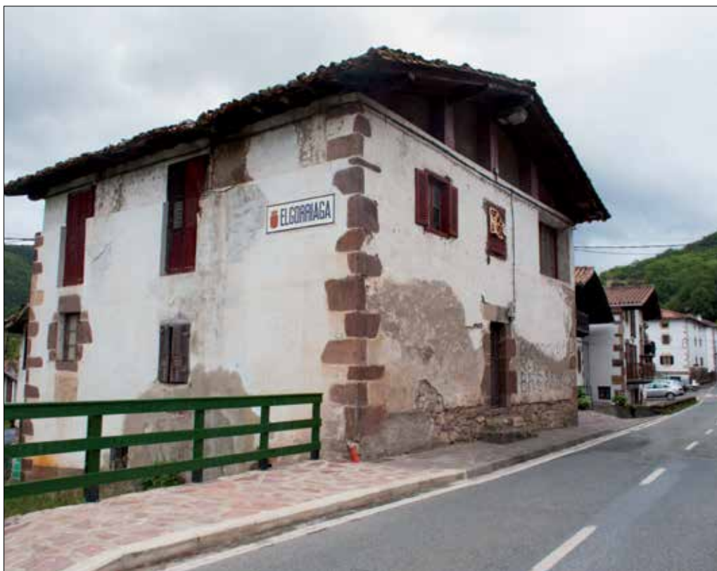
Antigua casa del cura, a la entrada del pueblo.
